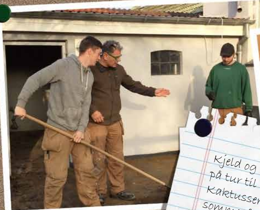
Ulf, Sebastian og Jasper har været i gang med flisebelægning på Ebeltoftvej.
