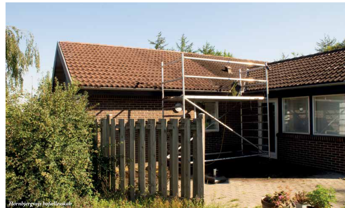
Mickey pudser vinduer og døre, inden de skal males.
